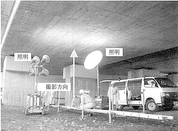
写真-2 ひび割れ画像撮影状況（全景）
