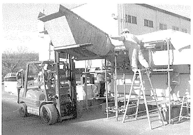
(b) 高流動コンクリートの打込み状況
