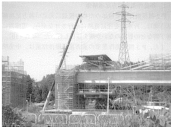
写真 - 16 側径間部の施工
