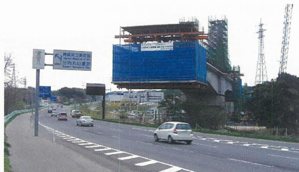
写真 - 2 張出し架設状況
