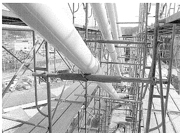
写真 - 11 保護管固定状況
