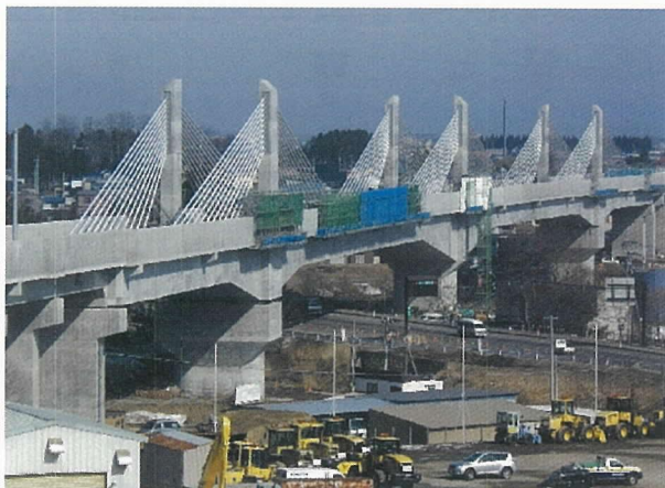
写真 - 1 施工全景
