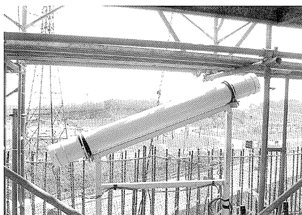
写真 - 12 ダミー斜材設置
