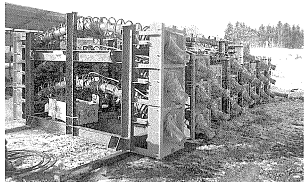
写真-7 サドルユニット化
