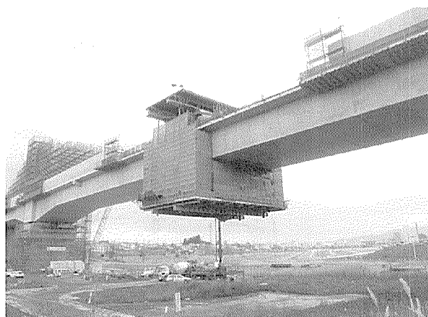
写真 - 17 中央閉合部の施工
