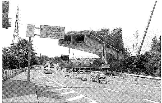
写真-19 移動作業車解体時の規制状況
