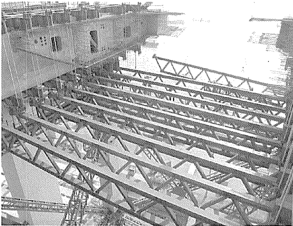
写真-4 コンクリート桁構築用トラス
