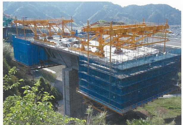
写真-5 張出し架設状況
