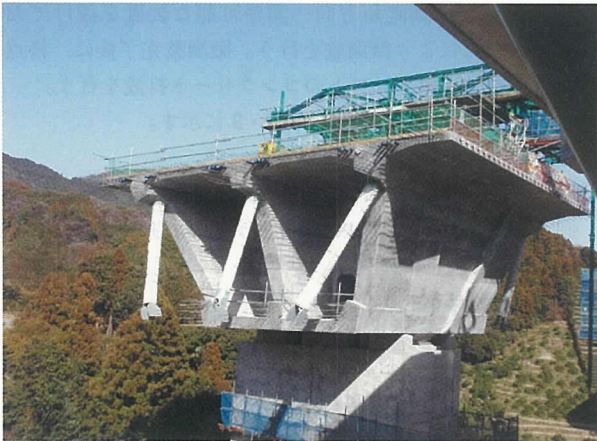
写真-3 柱頭部外観
