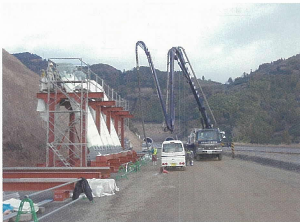
写真-4 鋼トラス材への充てんコンクリート打設
