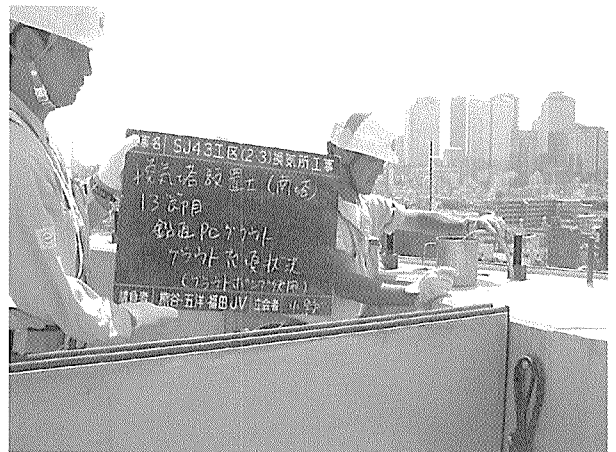
写真 - 7 鉛直 PC グラウト注入状況
