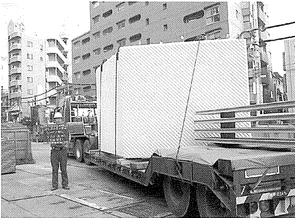
写真 - 2 セグメントの現場搬入
