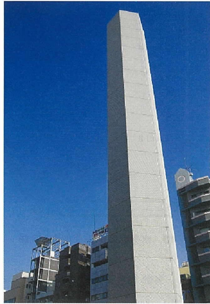
写真 - 9 完成写真（排気塔）
