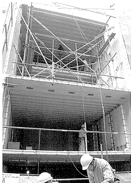
写真 - 6 建方風景
