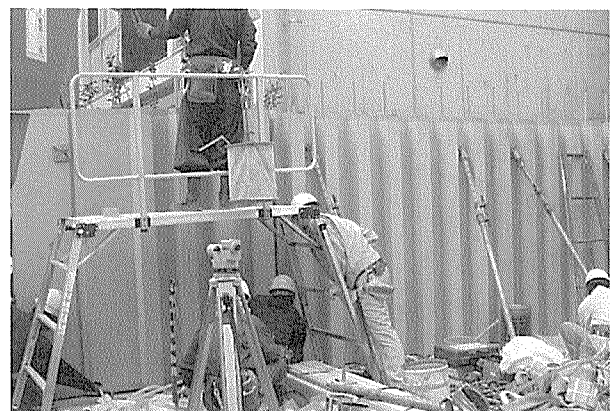
写真-4 壁 PC 部材建方
