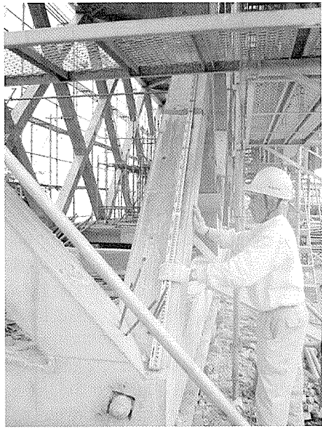
写真-6 コンクリートトラスの計測
