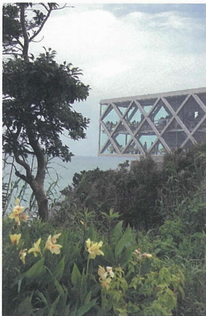
写真 - 15 竣工写真 2
