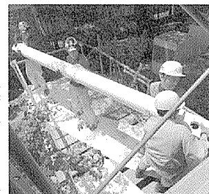
写真 - 5 ブレース運搬
