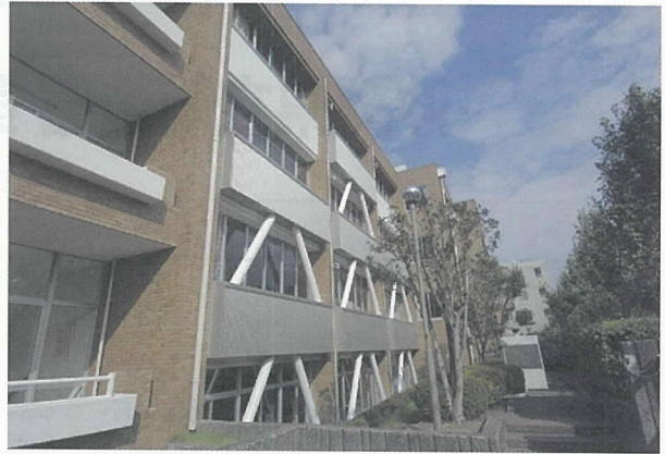
写真 - 10 完成外観
