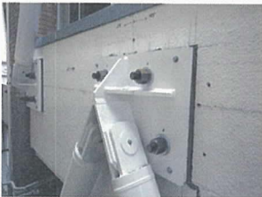
写真 - 7 圧着接合状況
