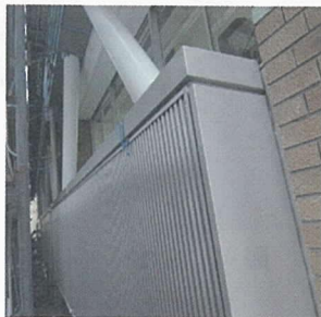
写真 - 9 パネル設置
