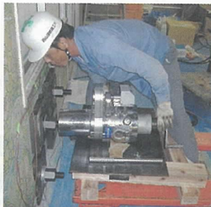
写真 - 8 PC 鋼棒緊張作業
