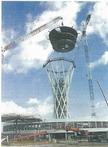
図 - 10 上部構造の設置
