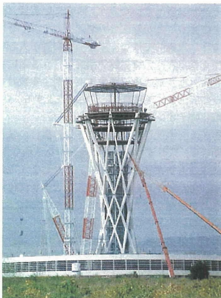
図 - 11 躯体工事の最終段階
