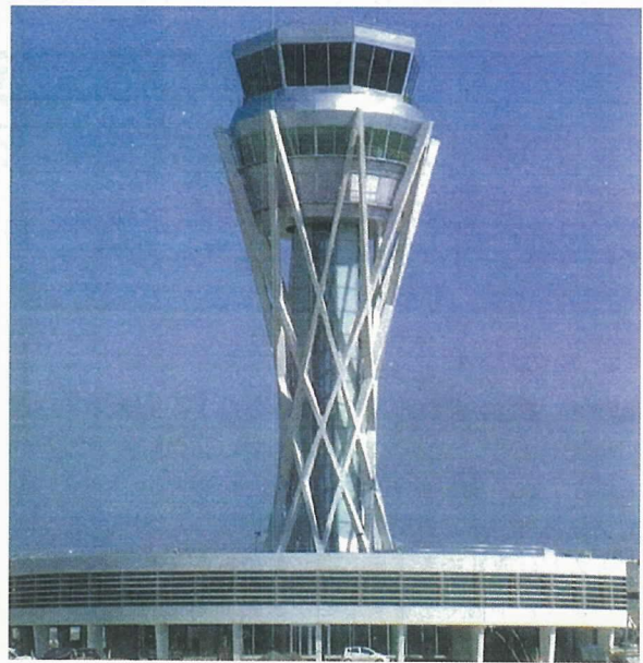
図 - 12 新管制塔の全景
