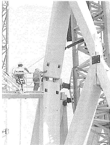
図-5 ノード部分の建方
