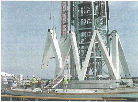
図 - 9 プレキャスト部材の建方
