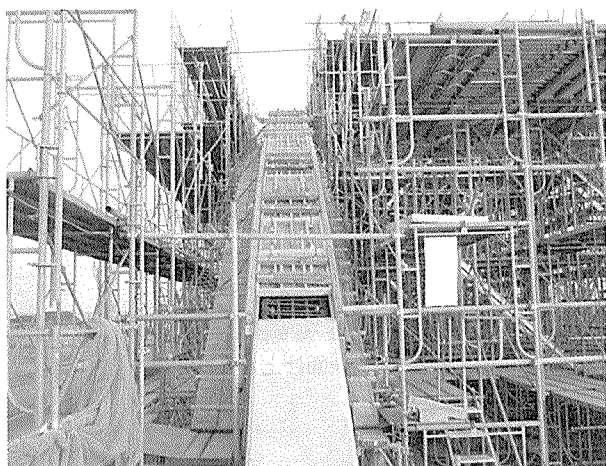
写真 - 1 アーチリブ伏せ型枠
