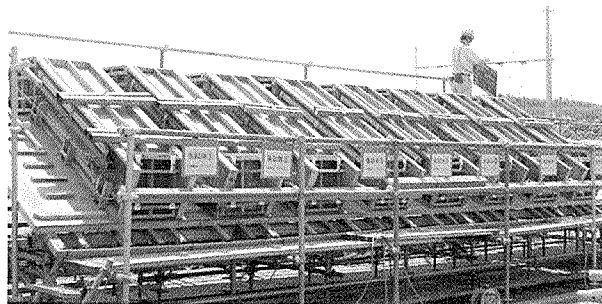
写真-4 仕上げ確認用試験体
