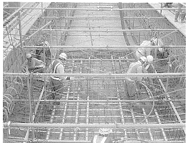
写真 - 7 補剛桁コンクリート打設状況
