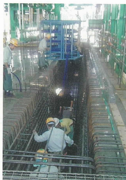
写真-4 ケーブル配置状況
