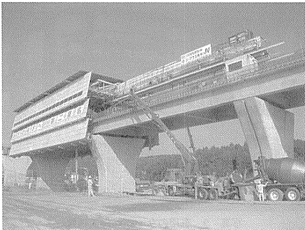
写真 - 5 コンクリート打設状況
