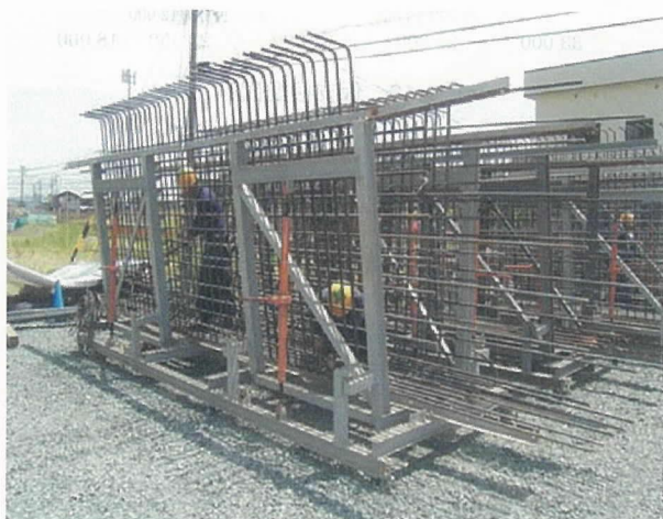
写真-1 ウェブ鉄筋のプレファブ化
