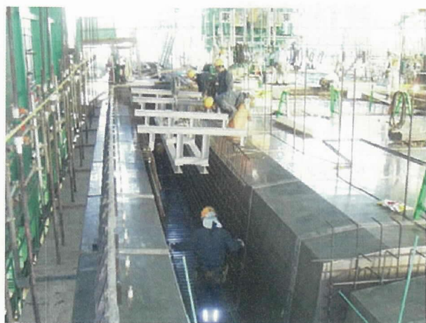
写真-2 プレファブ鉄筋の型枠内へのセット状況
