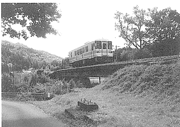
写真 - 1 第一大戸川鉄道橋
