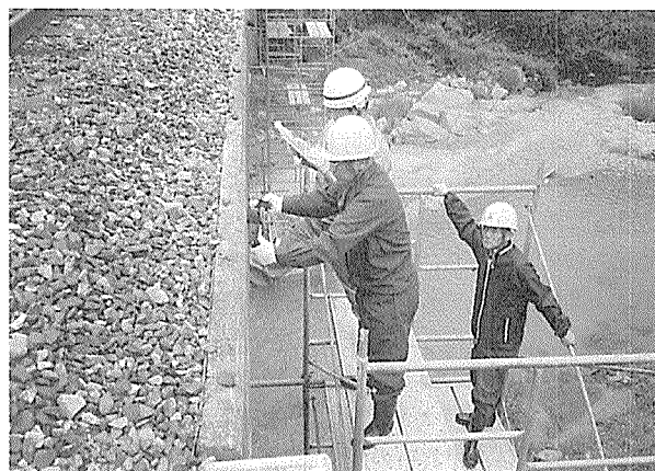
写真 - 5 第一大戸川橋梁 PC 桁のクリープ測定
