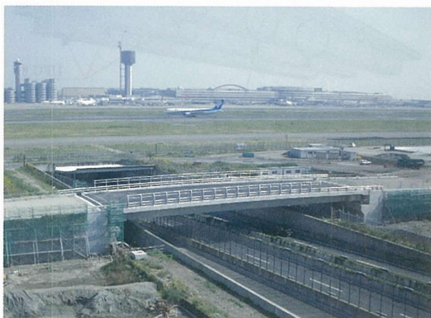
写真 - 1 GSE 橋梁 全景（施工中）
