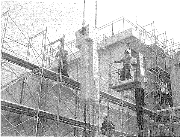
写真-7 PCa 柱建方状況
