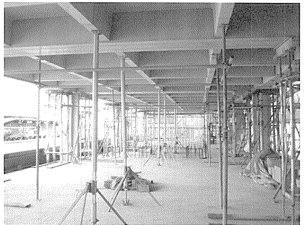
写真-11 PCa 床版建方状況
