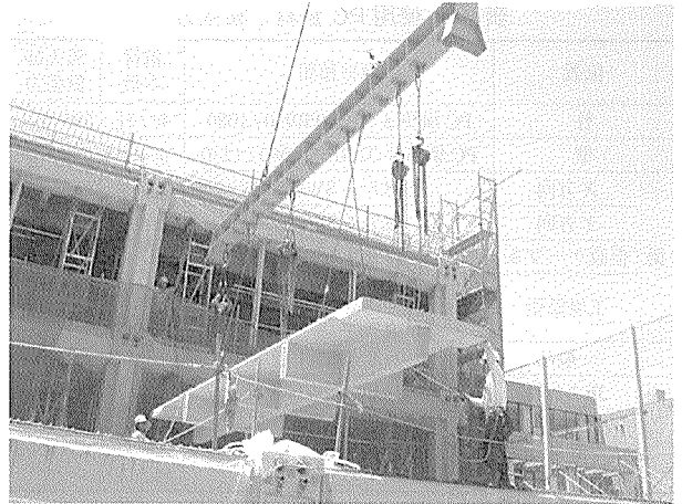
写真-10 PCa 床版建方状況
