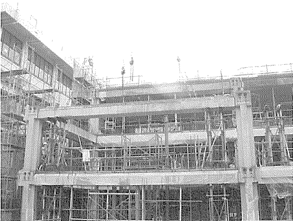
写真-9 PCa 壁版建方状況
