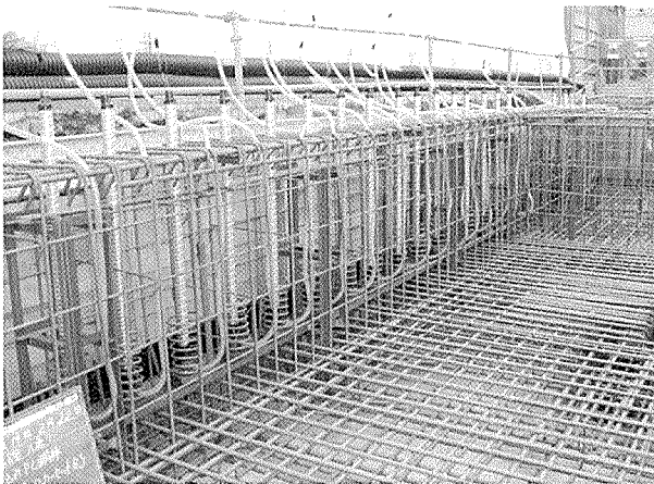
写真 - 6 埋込み PC 鋼棒セット状況 (PCa 壁版)
