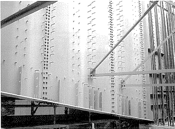
写真-4 プレートジベル接合
