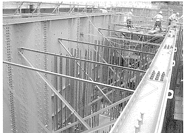
写真-7 波形鋼板の先行架設
