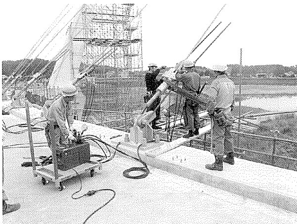
写真-2 ハンガーケーブル引込み状況
