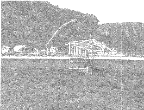
写真-7 中央連結打設状況
