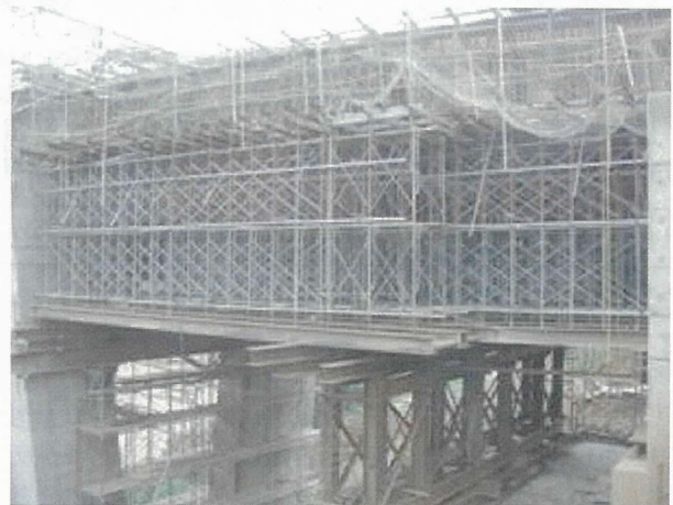
写真-15 支柱式支保工による単純箱桁施工
