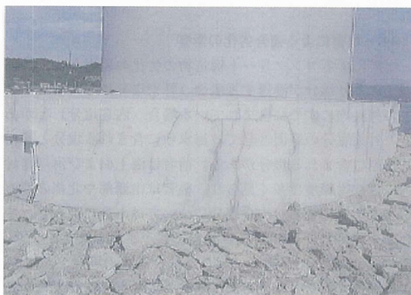
写真 - 9 A 橋の外観状況 (P1 橋脚)
