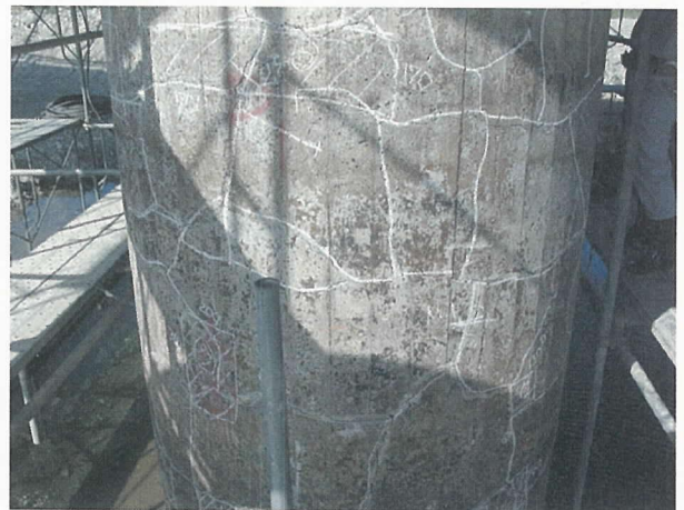
写真 - 11 D 橋の外観状況 (P1 橋脚)
