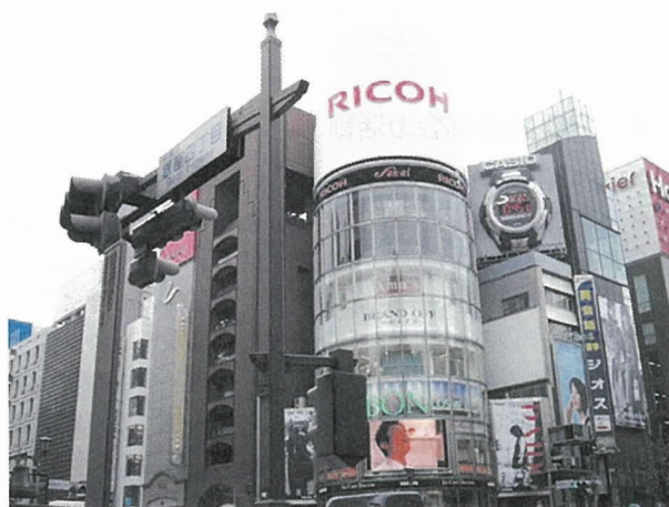
写真-6 三愛ビル（1962 年竣工、5 階から屋上まで 6 フロアが分割プレキャスト PC スラブでリフトアップ工法により施工された。2008 年 12 月筆者撮影）
