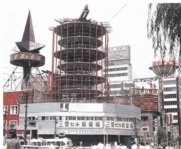
写真-7 施工中の三愛ビル（株）ピーエス三菱提供）
