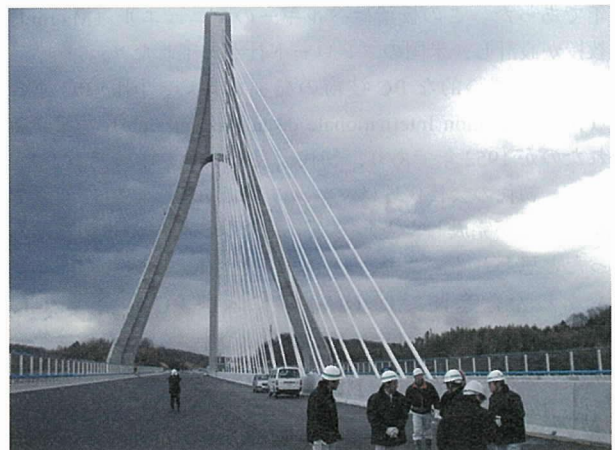
写真-4 完成時の矢作川橋 (2005年1月筆者撮影)
