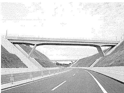
写真 - 2 PC 斜材付き \pi 形ラーメン橋
