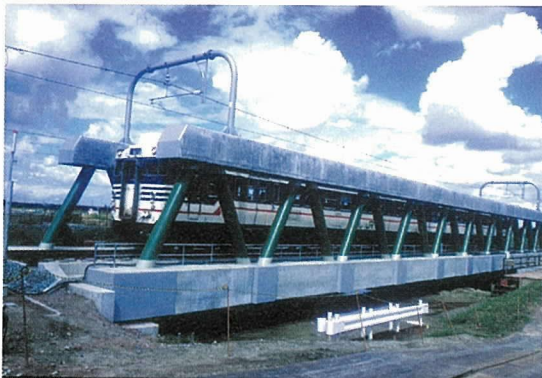
写真 - 10 羽越本線山倉川橋梁
