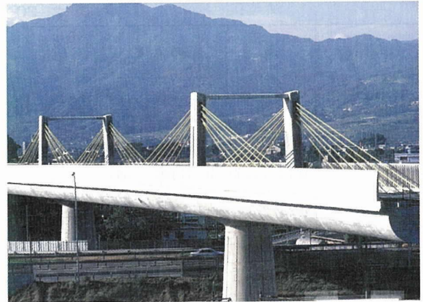
写真 - 5 北陸新幹線屋代川橋梁
