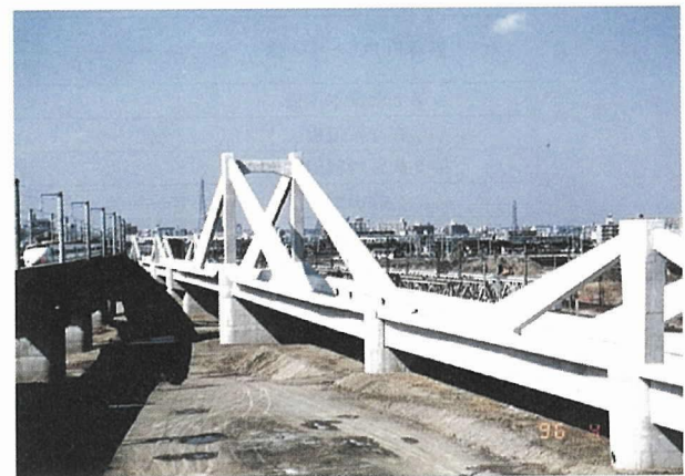
写真 - 6 東北本線名取川橋梁
