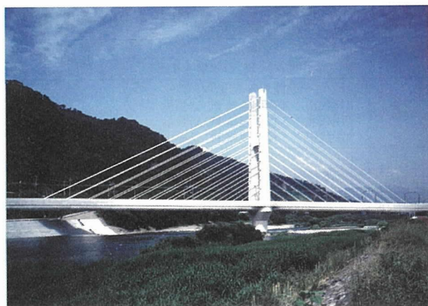
写真 - 4 北陸新幹線第 2 千曲川橋梁
