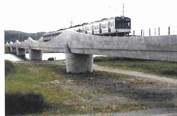
写真 - 7 仙石線鳴瀬川橋梁
