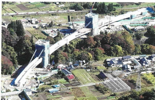
写真 - 11 吾妻線第 2 吾妻川橋梁
