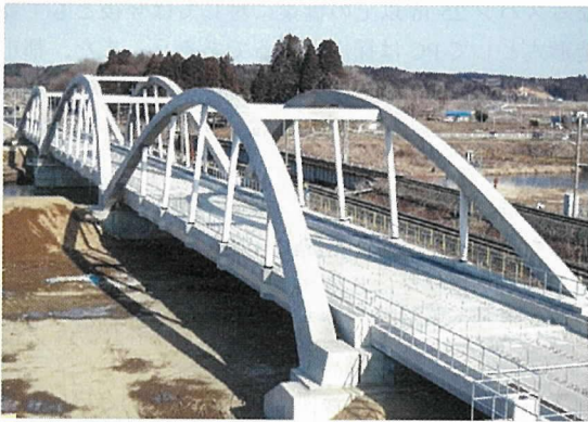
写真 - 8 東北本線天間川橋梁
