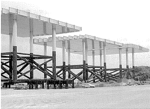
写真-2 据付け前のジャケッ ト
