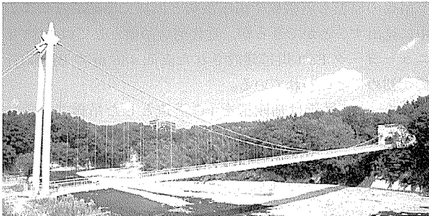
写真 - 23 大金吊り橋
