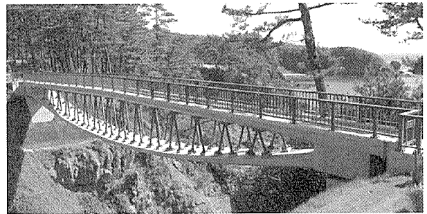
写真 - 18 巖門園地園路橋
