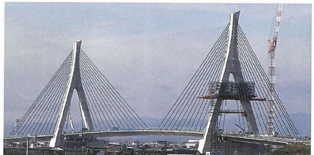
写真-5 矢部川橋
