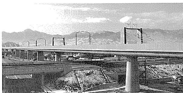
写真 - 9 屋代北・南橋梁
