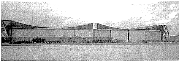
写真-27 フランクフルト空港の格納庫
