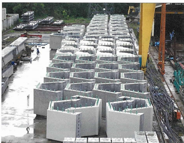
写真 - 7 PC 換気塔（部材仮置状況）
