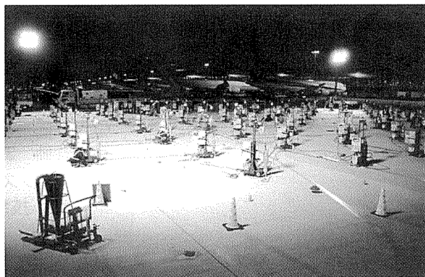
写真-2 リフトアップ状況
