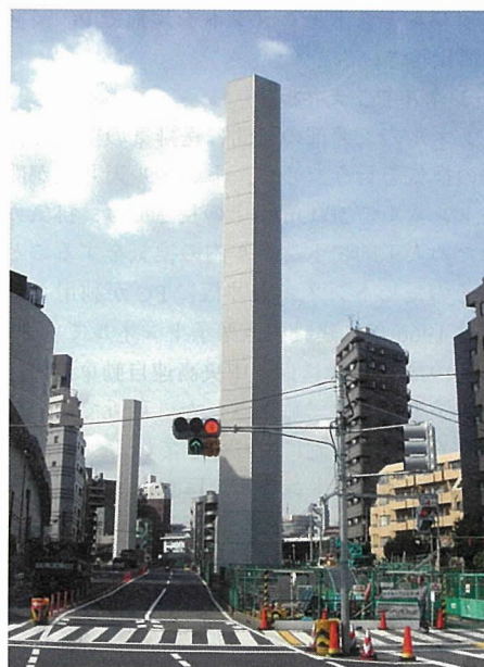
写真 - 8 PC 換気塔（全景）
