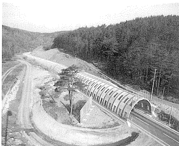
写真-4 スノーシェルター
