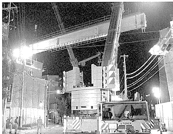
写真-2 大型油圧式クレーン架設
