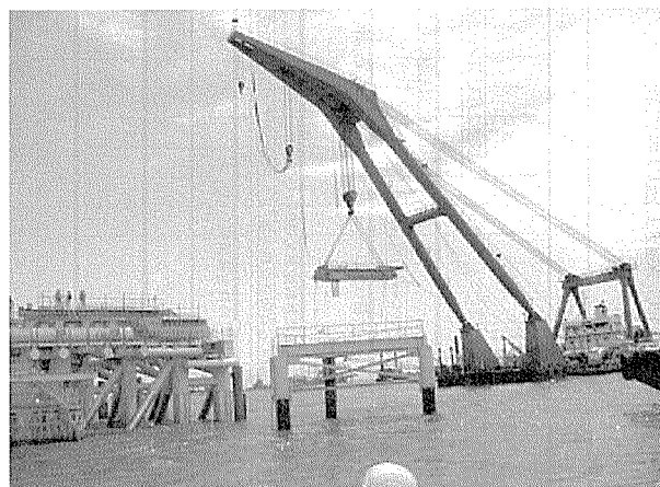
写真-3 フローティングクレーン架設
