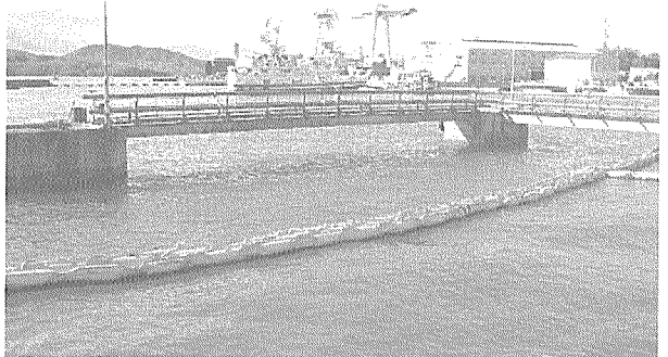
写真 - 3 カムテックス社の常石栈橋
