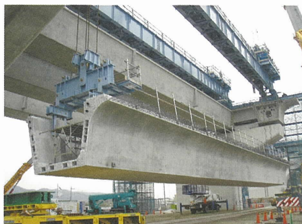
写真 - 2 茄子作高架橋の U 桁リフティング
