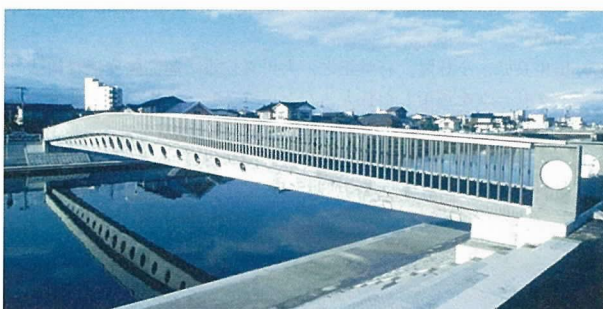
写真-1 橋梁への適用例(酒田みらい橋, 酒田市)
