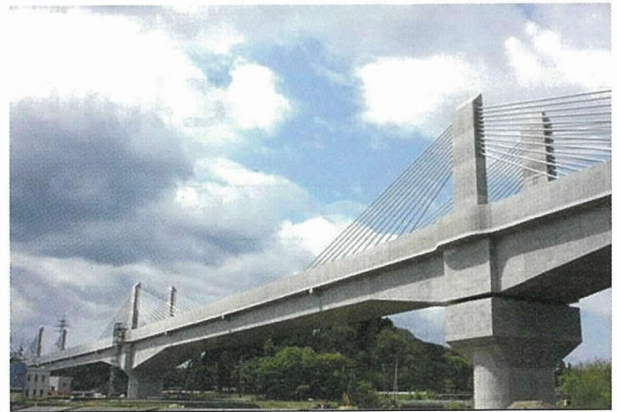
写真 - 3 斜ケーブルにエポキシ樹脂被覆 PC ストランドを用いた三内丸山 BL (写真提供 (株) 銭高組)
