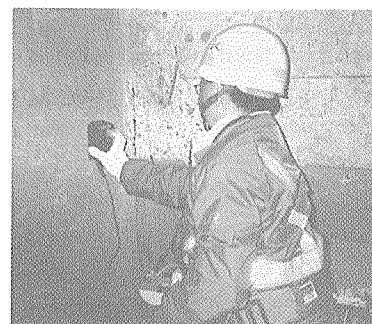
写真 - 4 鉄筋かぶり測定状況
