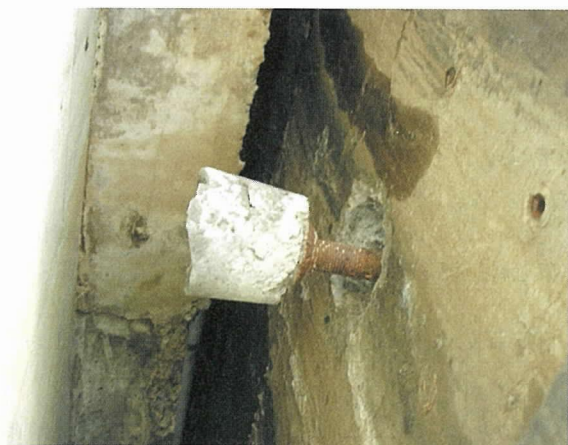
写真 - 1 横締め用 PC 鋼棒の破断・拔出し状況
