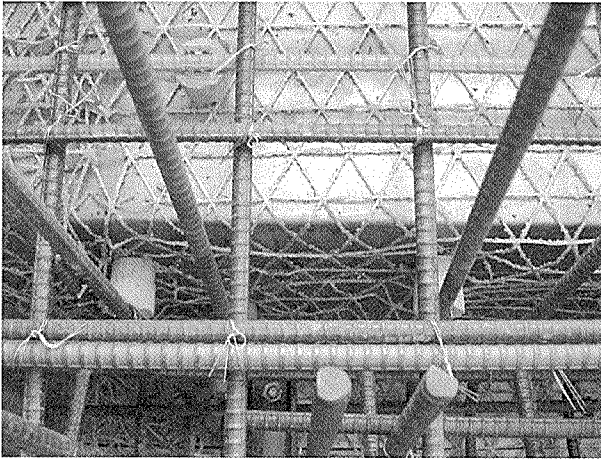
写真-2 はく落防止用メッシュシートの施工
