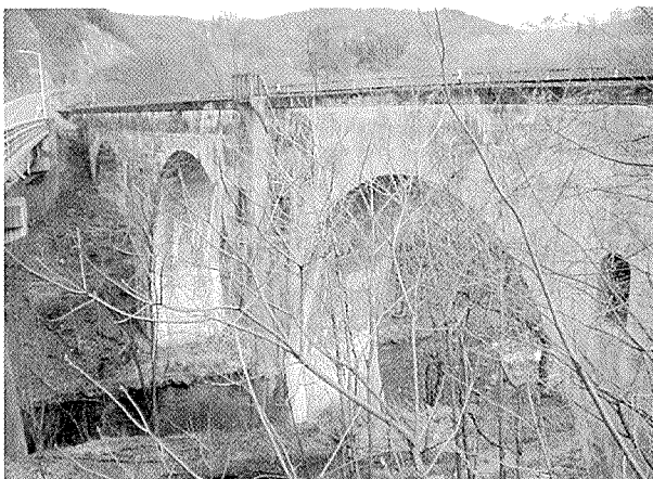
写真 - 8 岩根橋(達曾部川橋梁) (橋体に旧橋の鋼桁、橋台、橋脚が埋まっている)
