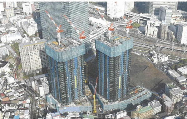
(1) 大崎駅西口中地区再開発建設所
