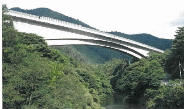
写真 - 1 八幡平橋全景
