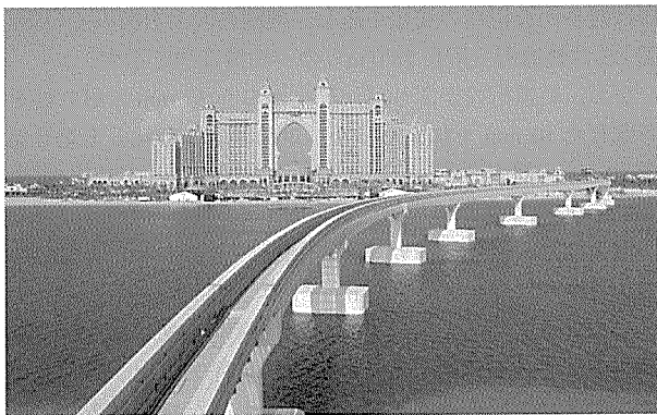
写真 - 2 MS3 ロングスパン橋の完成状況
