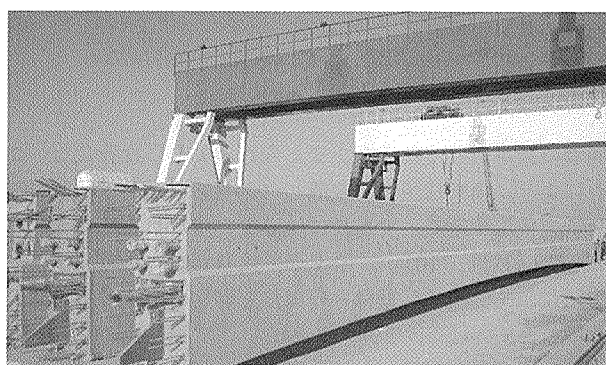
写真-6 軌道桁仮置き状況（ストックエリア）
