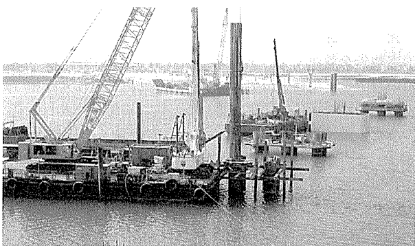
写真 - 11 杭構築状況
