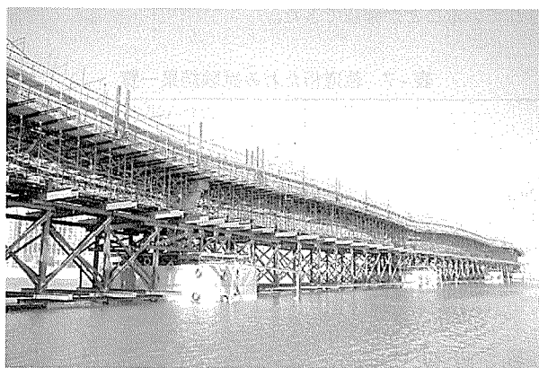
写真 - 13 オールステージング工法
