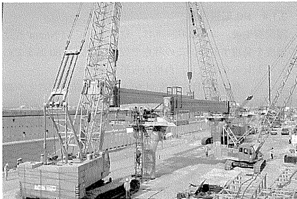
写真 - 8 クローラークレーンによる軌道桁架設
