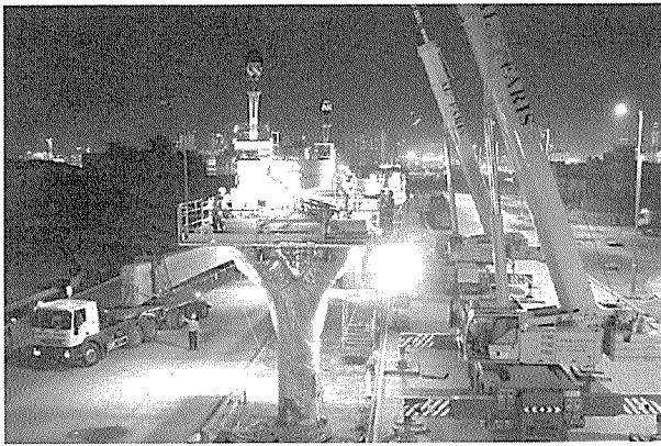
写真 - 7 トラッククレーンによる軌道桁架設
