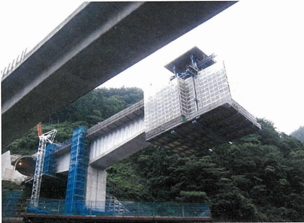
写真-9 P9 張出し架設状況
