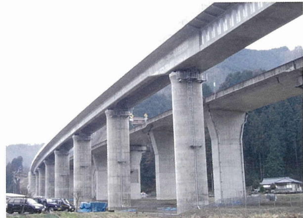
写真-11 PRC 2 主版桁部全景
