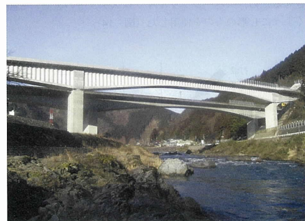
写真-12 波形鋼板ウェブ箱桁部全景
