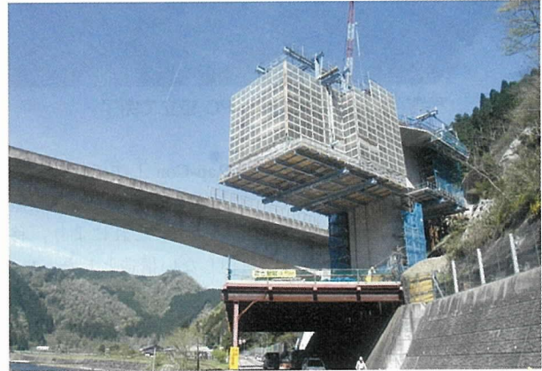
写真-10 国道防護工および防護パネル
