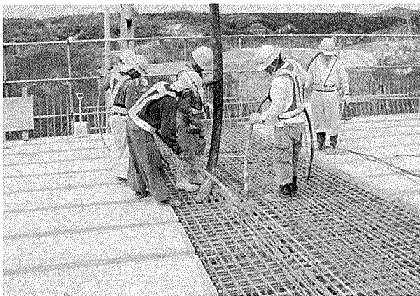
写真-7 連結部のコンクリート打設
