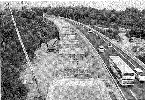
写真-3 対面交通規制下での施工状況
