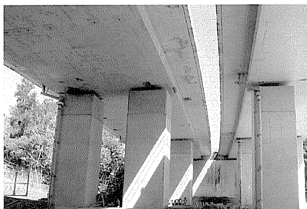
写真 - 1 億首川橋の RC 中空床版橋と 2 柱式橋脚
