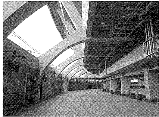
写真 - 4 放射方向の PCa 架構
