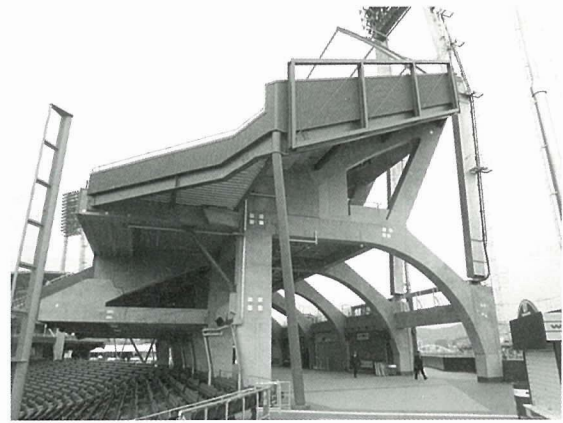
写真 - 3 パフォーマンスシートの構造
