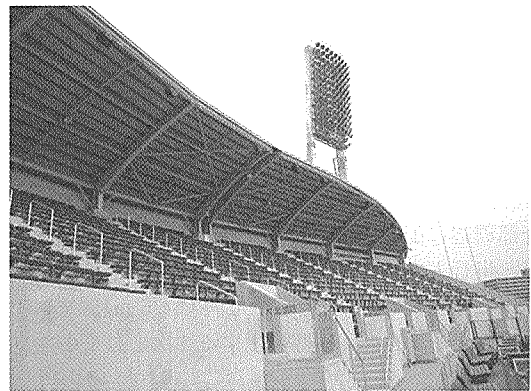
写真 - 8 鉄骨屋根
