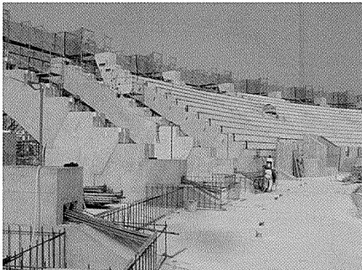
写真 - 6 段床部の PCa 床版
