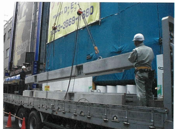
写真-9 架設状況 1
