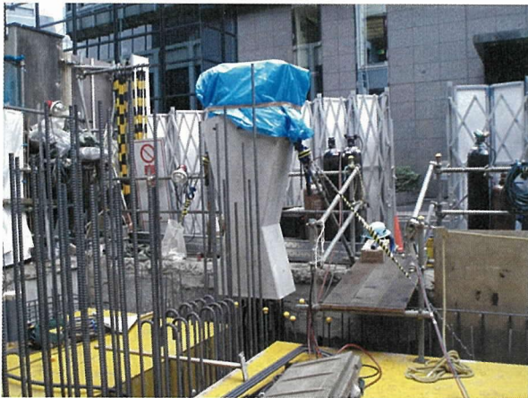
写真-7 最下段外郭 PC ブレース取り付け完了状況
