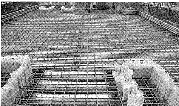
写真 - 2 ボイドスラブ状況
