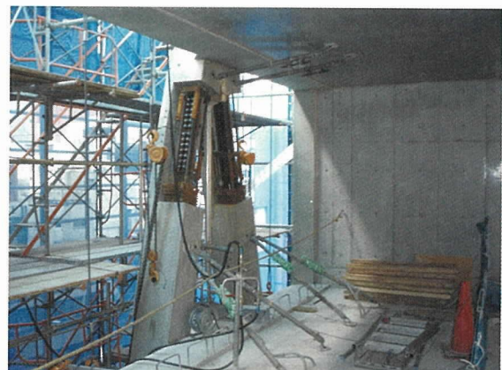
写真-11 部材固定状況
