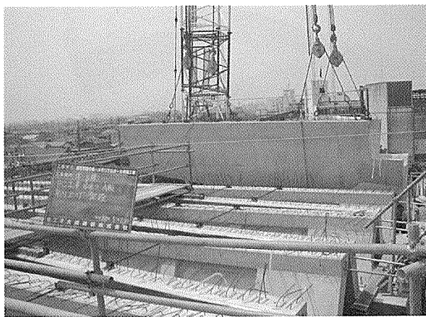
写真 - 9 部材吊込み状況
