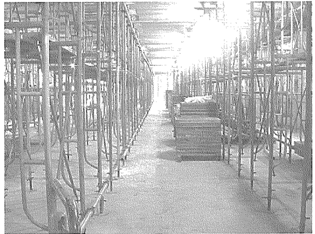
写真 - 12 ⑩ 支保工再支持 [Stage11]
