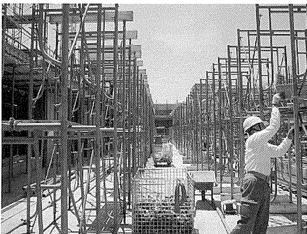
写真-4 ② 支保工組立て 中央部で 30 mm 程度の FR 板むくりを想定し、スラブ下支保工を設置する。
