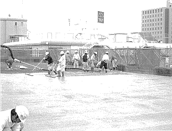
写真 - 9 ⑦ スラブ CON 打設 [Stage9, 14, 19]
