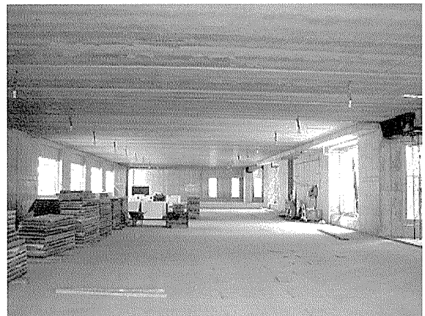
写真 - 14 ⑫ 支保工解体 [Stage20]
