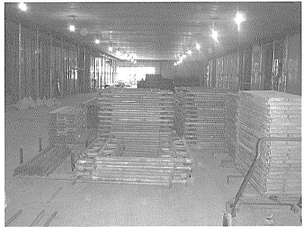
写真 - 13 ⑪ 中央部支保工解体
