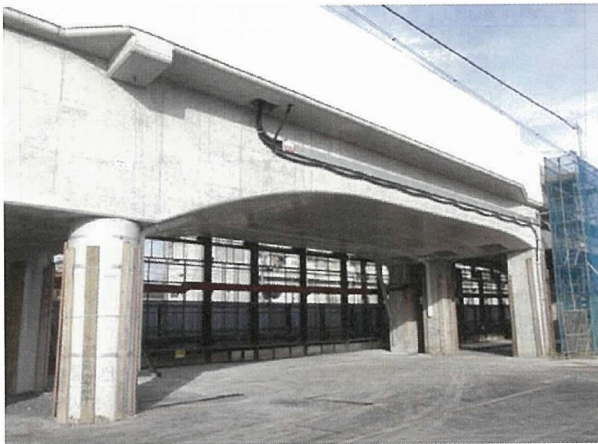
写真 - 1 中央線 PRC1 ラーメン高架橋
