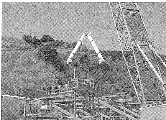
写真 - 4 鋼トラス材架設状況
