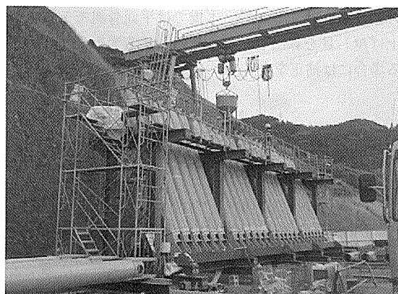
写真 - 6 下床版側格点部コンクリート充てん状況
