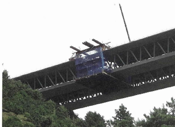
写真-7 中央閉合部の施工状況
