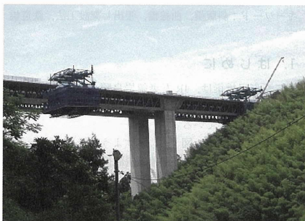
写真-8 張出し施工状況(巴川橋)
