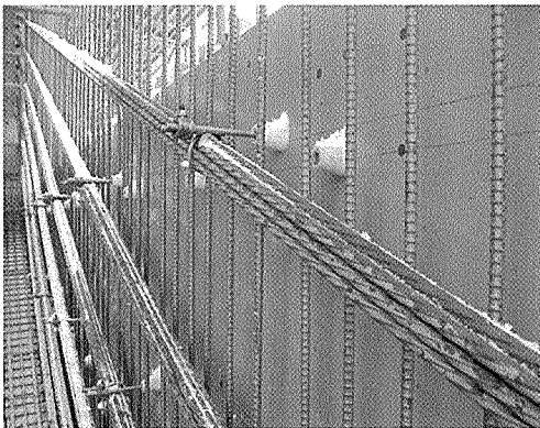
写真-10 位置決め金具設置状況
