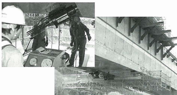
写真 - 12 ラック足場上での緊張作業
