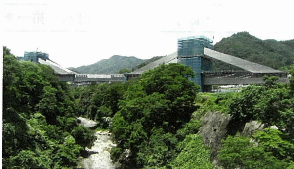
写真 - 13 平成 21 年 6 月末施工状況
