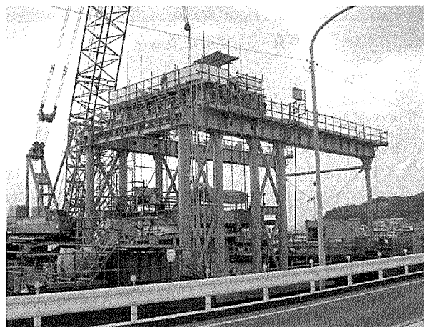
写真-8 PSM式支持圧入装置
