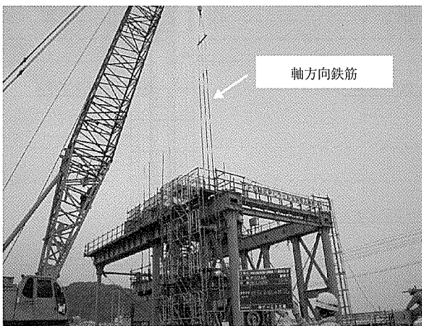
写真 - 10 軸方向鉄筋挿入
