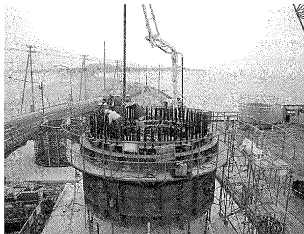
写真-5 コンクリート打設
