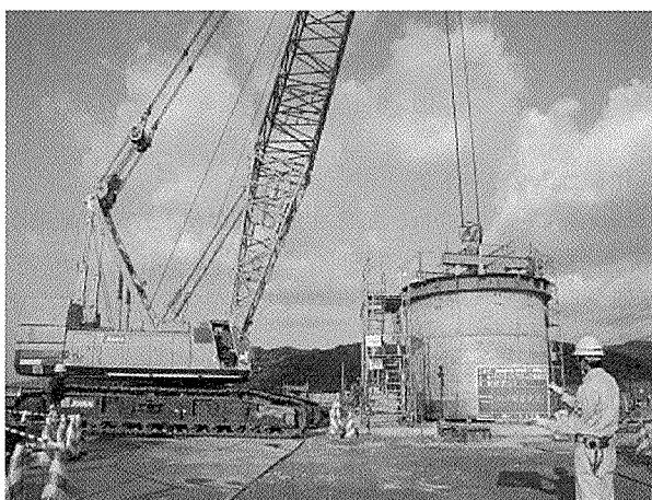
写真-6 単体ブロック吊上げ
