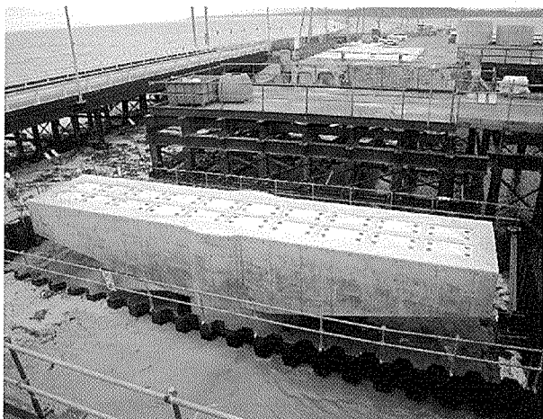
写真 - 12 橋脚工完了
