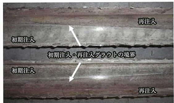
写真 - 2 再注入後のグラウト充てん状況
