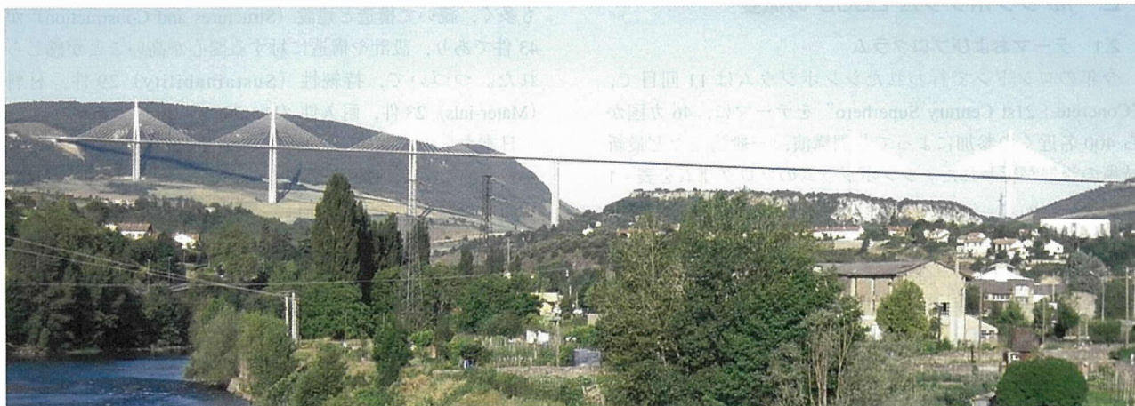
写真 - 2 ミヨー市街から見たミヨー高架橋
