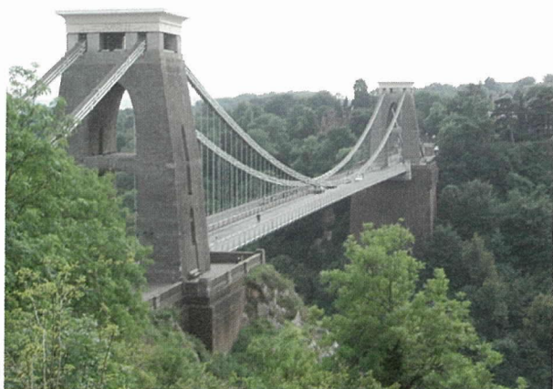
写真-8 クリフトン吊橋
