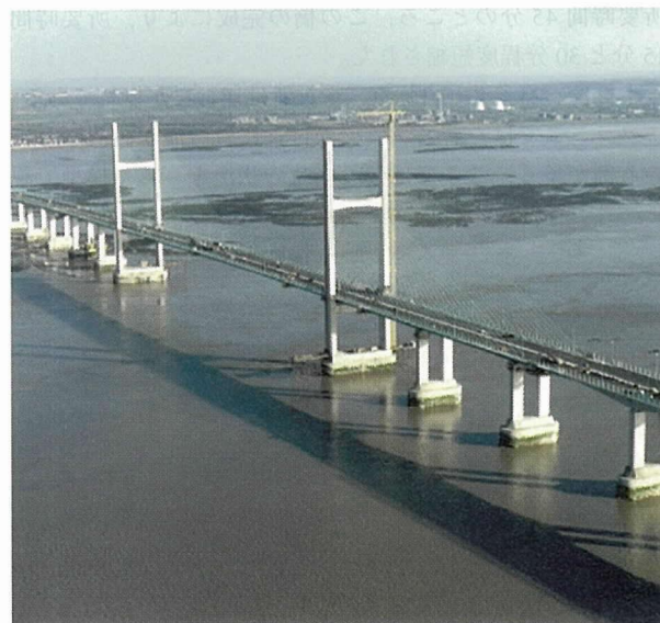
写真-7 第2セバーン橋(斜張橋部分)
