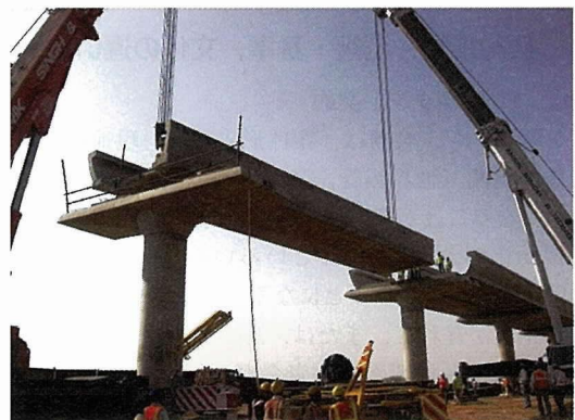
写真-3 デリーメトロ2期工事 U型桁の架設状況
