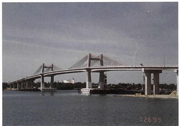
写真-2 フィリピン第2マクタン橋
