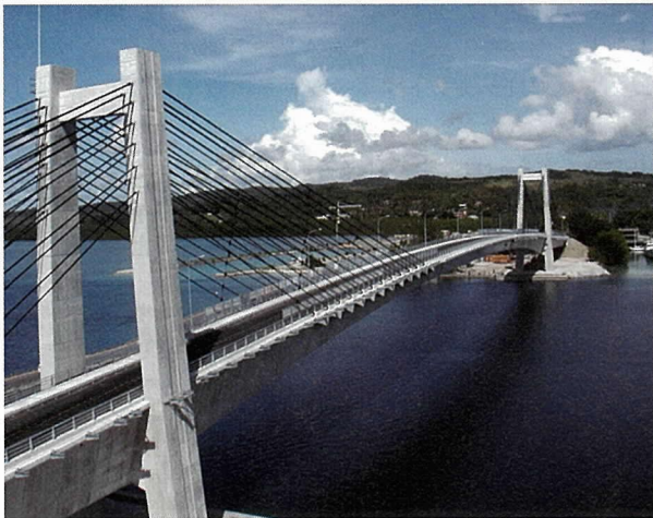
写真-1 日本・バラオフレンドシップ橋
